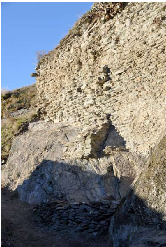
Fig. 2: Muralla est prop d'on estaria la porta d'accés al castell, amb els dos contraforts
