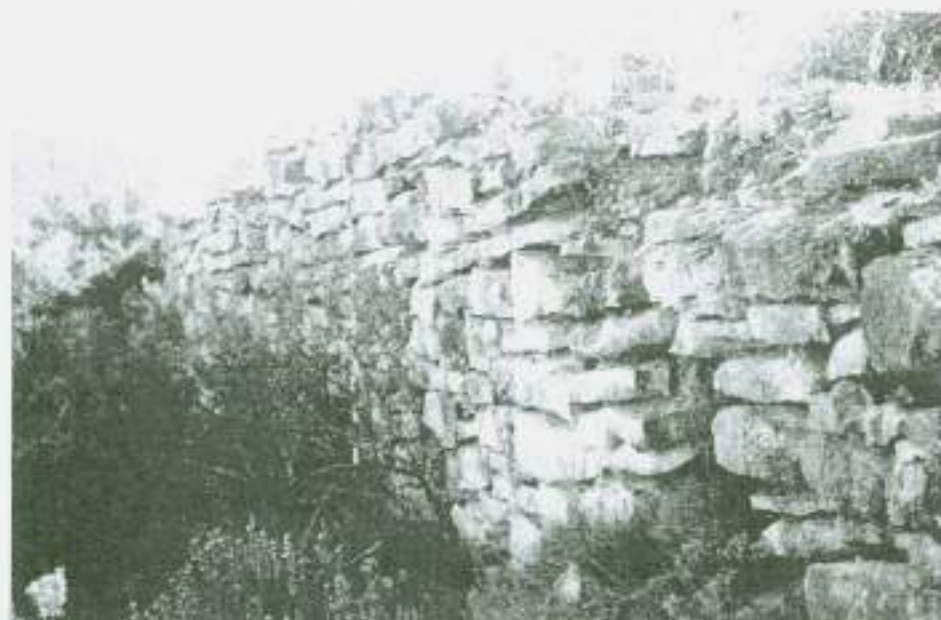
Fot. 12. Muralla oriental del poblado del Castell dels Moros (Fot. Equip Montmeneu)
